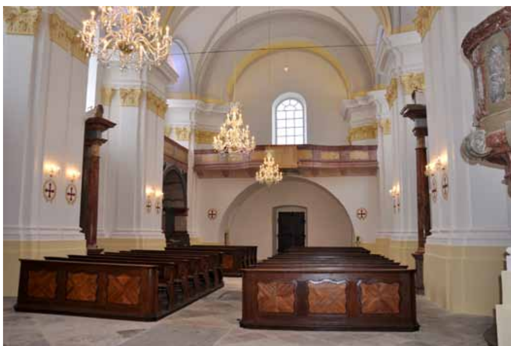
Obr. 10–13. Kostel Konojedy, stav před a po opravě. Foto: Kamila Hlaváčková 2014–2016.
