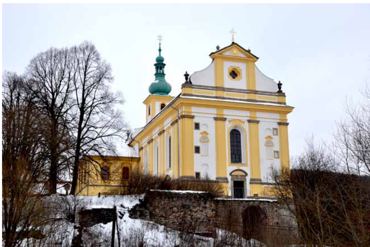
Obr. 8–9. Kostel Konojedy, stav před a po opravě. Foto: Kamila Hlaváčková 2014–2016.
