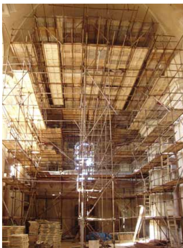
Obr. 7. Kostel Konojedy, prostorové lešení. Foto: Stanislav Flesar, říjen 2015.
