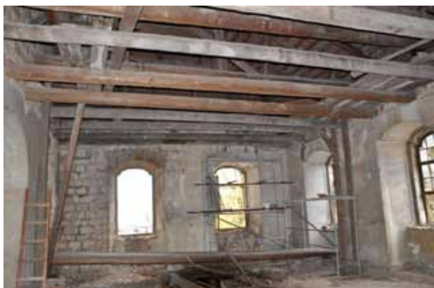
Obr. 14–15. Kostel Konojedy, stav před a po opravě. Foto: Kamila Hlaváčková 2014–2016.
