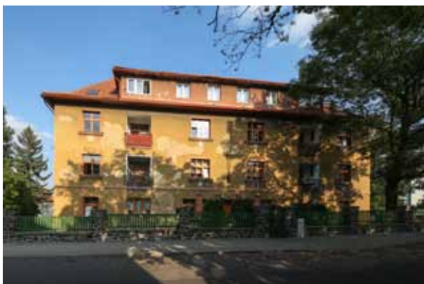
Obr. 13. Pohled na západní průčelí domu pro státní zaměstnance č. p. 1532 v Mostě od F. A. Libry, foto: M. Pavlíková, srpen 2016.
