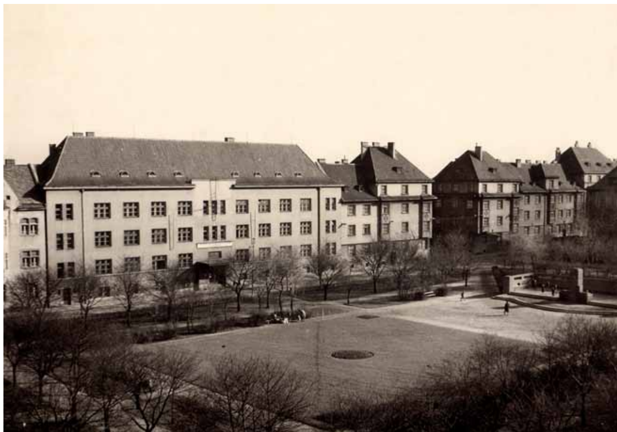
Obr. 26. Státní hornický dům v Břeštonech, František Albert Libra, realizovaná perspektiva, leden 1933, zdroj: NTM v Praze, AAS, fond Libra.
