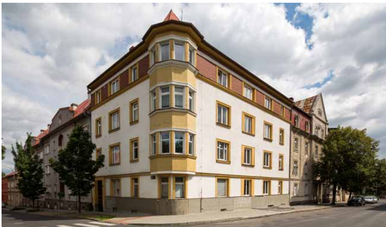
Obr. 12. Pohled na dům pro železniční zřízence č. p. 1665 v Chomutově od Karla Wintera, foto: M. Pavlíková, srpen 2016.
