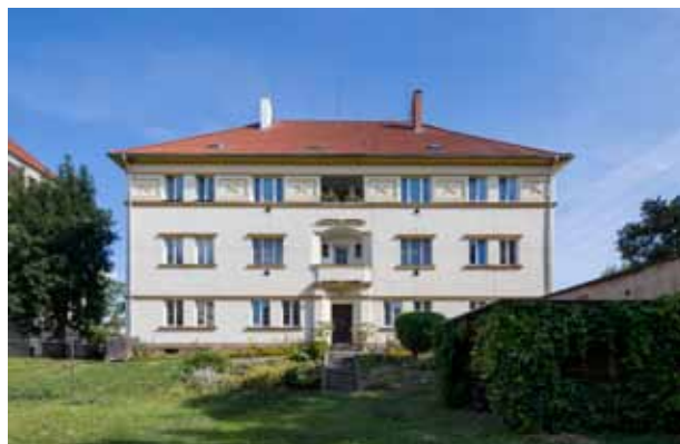
Obr. 6. Pohled na dvorní průčelí domu č. p. 996 pro státní zaměstnance v Litoměřicích od Bohumila Hübschmanna, foto: M. Pavlíková, srpen 2016
