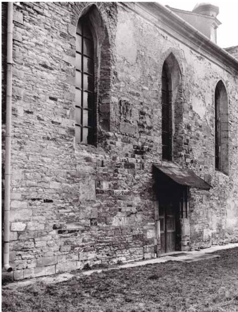
Obr. 28. Jižní průčelí lodi v pohledu od jihozápadu, inv. č. negativu 85960. Foto: NPÚ ÚOP Ústí nad Labem, 1989. Pod levým oknem a po levé straně okna pravého jsou patrné větší kvádry nárožního armování střední části lodi. Po pravé straně levého okna se v cihelné vyzdívice nachází pískovcová nápisová deska a erb rytířů z Adláru. Po levé straně portálu je zřetelná vertikální spára dokládající jeho druhotné osazení.
