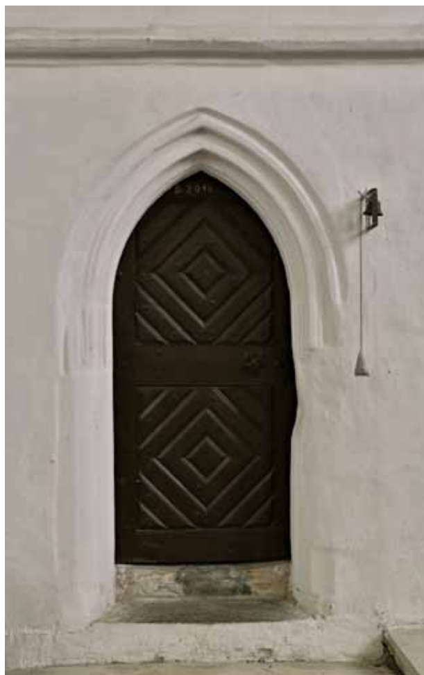
Obr. 20. Čelní pohled od jihu na portál vedoucí z presbytáře do sakristie. Foto: Kateřina Neumannová, 2016.
