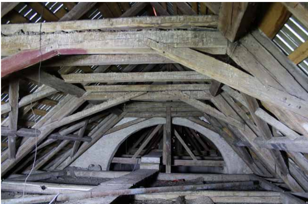
Obr. 27. Krov lodi v pohledu od jihozápadu. Foto: Jaroslav Skopec, 2017.
