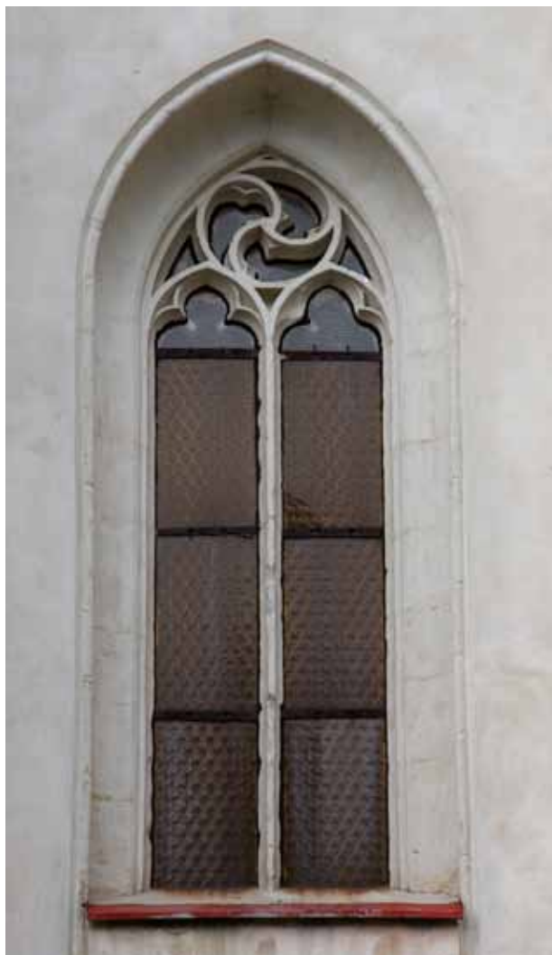
Obr. 16. Čelní pohled od východu na východní okno presbytáře. Foto: Kateřina Neumannová 2016.
