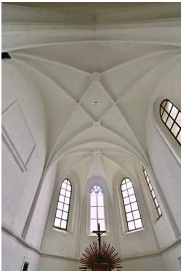
Obr. 11. Podhled do presbytáře od západu. Foto: Kateřina Neumannová, 2016.
