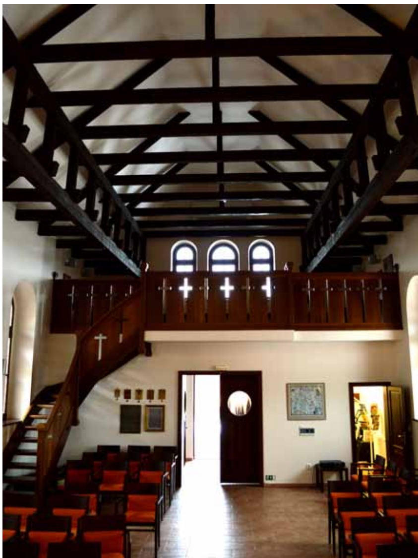
Obr. 12. Pohled ke kruchtě a do otevřeného krovu. Foto: Václav Zeman, 2017.
