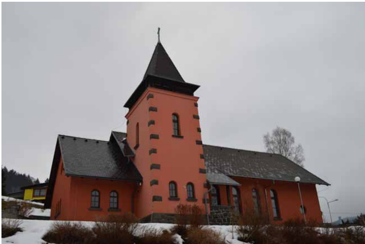
Obr. 1. Současný pohled na kostel po dostavbě a rozšíření. Foto: Václav Zeman, 2017.
