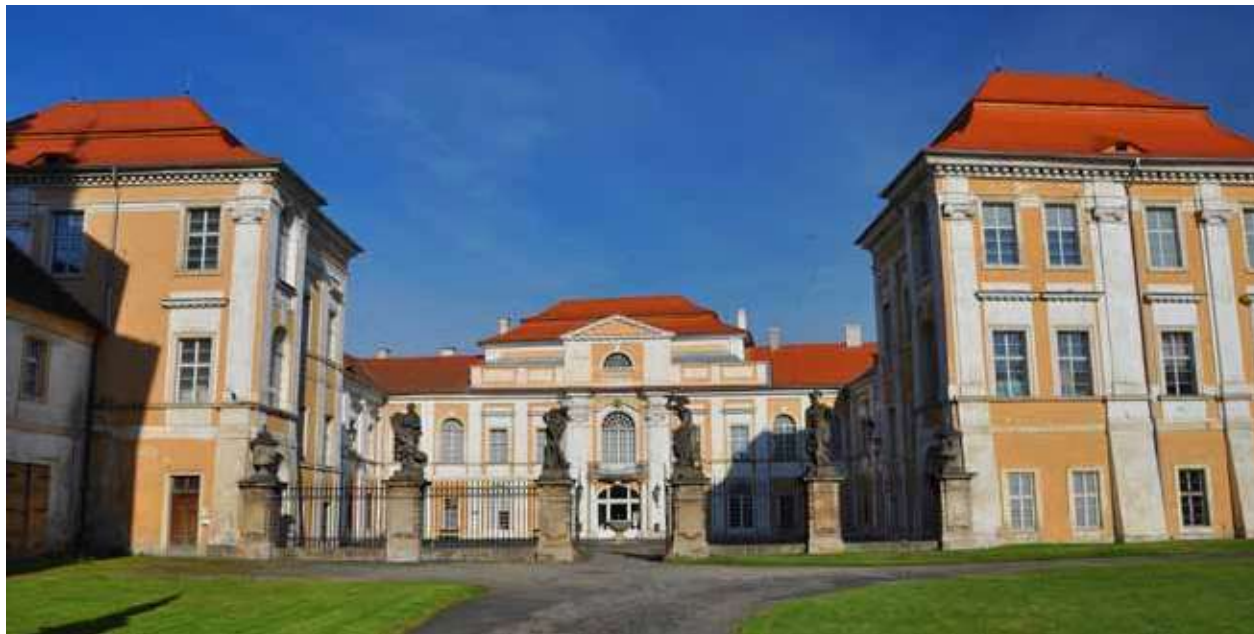
Obr. 1. Průčelí zámku Duchcov, východní strana, stav v roce 2017. Foto: Marian Hochel.
