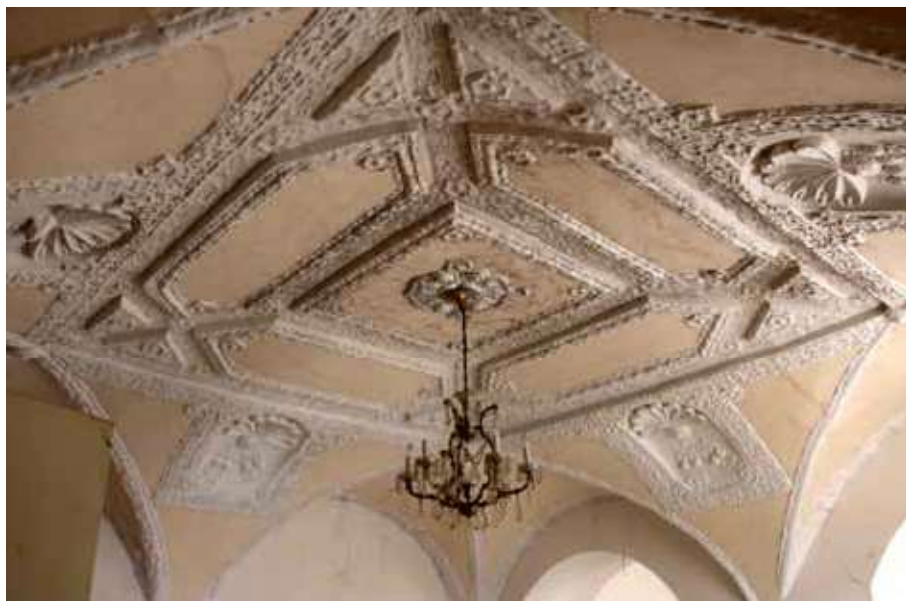
Obr. 2. Zahořany, zámek, přízemí jižního křídla, jižní místnost, detail štukové výzdoby klenby. Foto: David Skalický, 2017.
