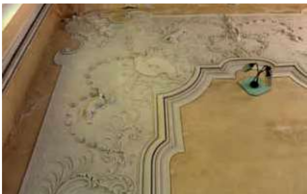
Obr. 9. Zahořany, zámek 1. patro východního křídla, detail SV rohu štukové výzdoby stropu sálu. Foto: Roman Švec, 2018.
