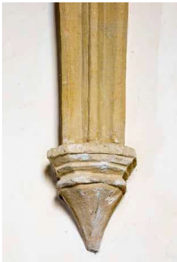
Obr. 8. Čelní pohled na jižní konzolu presbytáře. Foto: Marta Pavlíková, 2018.
