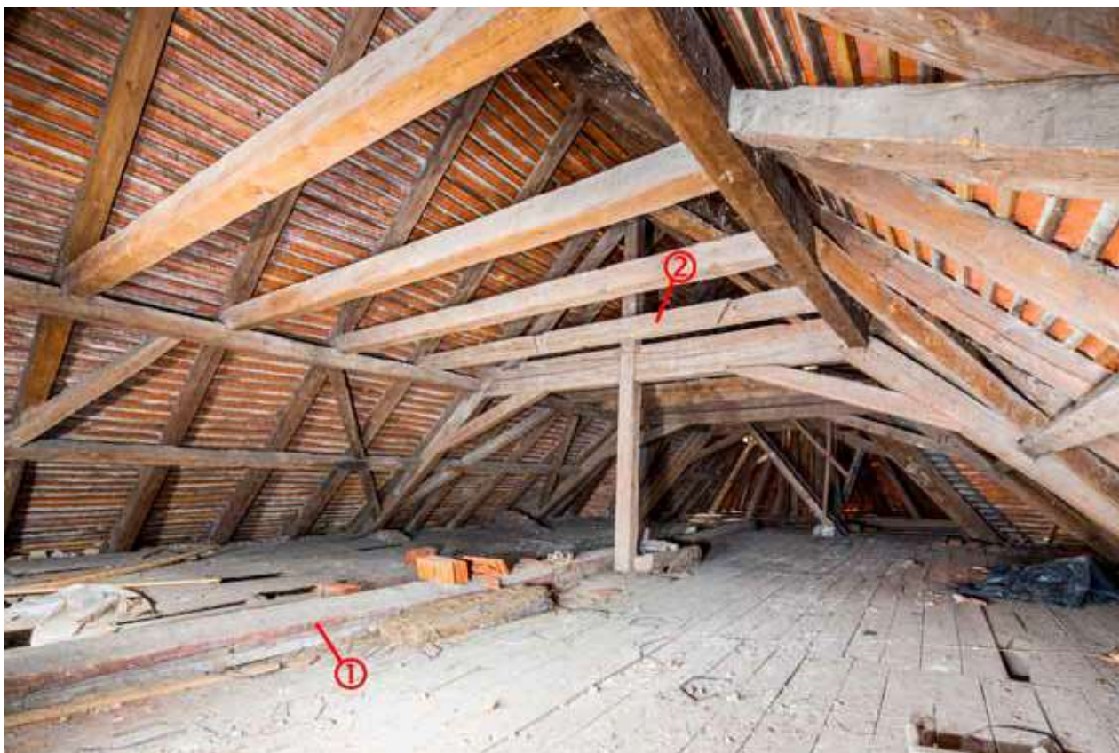
Obr. 11. Krov lodi v pohledu od jihozápadu. 1 – Druhotně užitý průvlak středověkého stropu lodi. 2 – druhotně užitý hambalek středověkého krovu. Foto: Marta Pavlíková, 2018.
