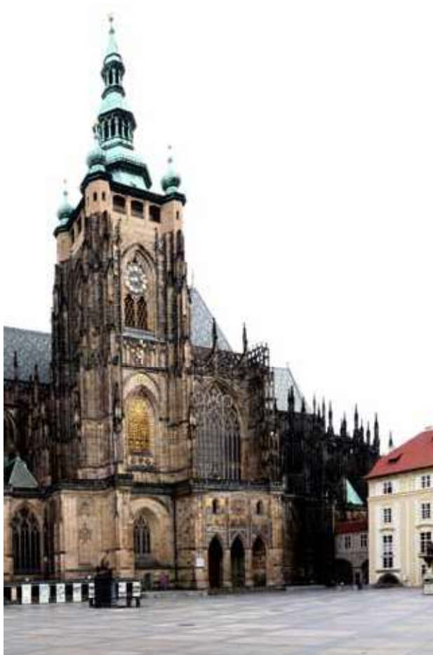
1) Katedrála sv. Víta, Václava a Vojtěcha, umístění jižního větenuvitého schodiště, situované až v úrovni balustrády nad kaplovou římsou. Foto: K. Kovářová.
