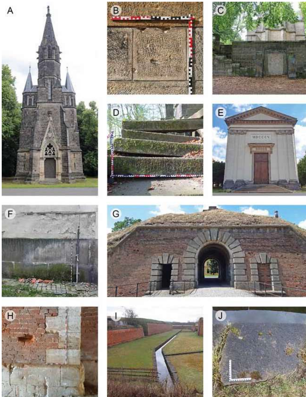
2/1) Lokalizace odběru stavebního kamene na historických stavbách. A – hlavní průčelí kaple sv. Jana Nepomuckého v Děčíně-Podmoklech; B – vzorek D1 odebrán z opadu kvádrového zdiva v severovýchodním průčelí kaple; C – hlavní průčelí Thunovské hrobky u kaple sv. Jana Nepomuckého v Děčíně-Podmoklech; D – vzorek D2 odebrán z opadu schodu spodního ramene západního schodiště; E – hlavní průčelí kostela Vzkříšení Páně v Terezíně; F – vzorek D3 odebrán z opadu obkladu soklu severozápadní zdi závěru kostela; G – severovýchodní průčelí Horní vodní brány v Terezíně; H – vzorek D5 odebrán z destrukce armování v jihovýchodní zdi průjezdu; I – napouštěcí kanál příkopu u bývalé Bohušovické brány v Terezíně; J – vzorek D14 odebrán z destrukce korunní dlaždice jižní návodní zdi navigace kanálu u reduitu č. 16. Foto K. Podroužek.
