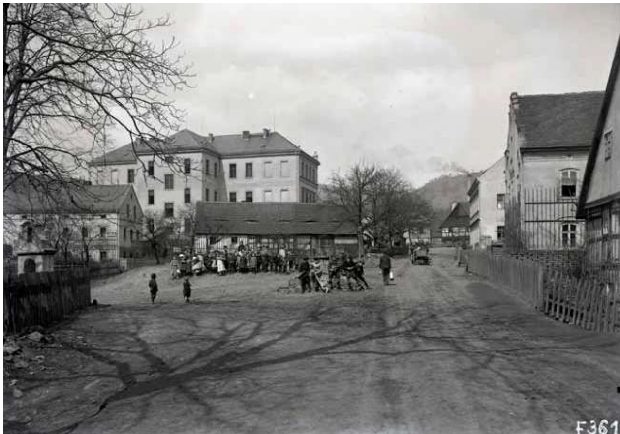
2) Škola v Neštětích se zbytky historické zástavby. Foto: Muzeum města Ústí nad Labem.
