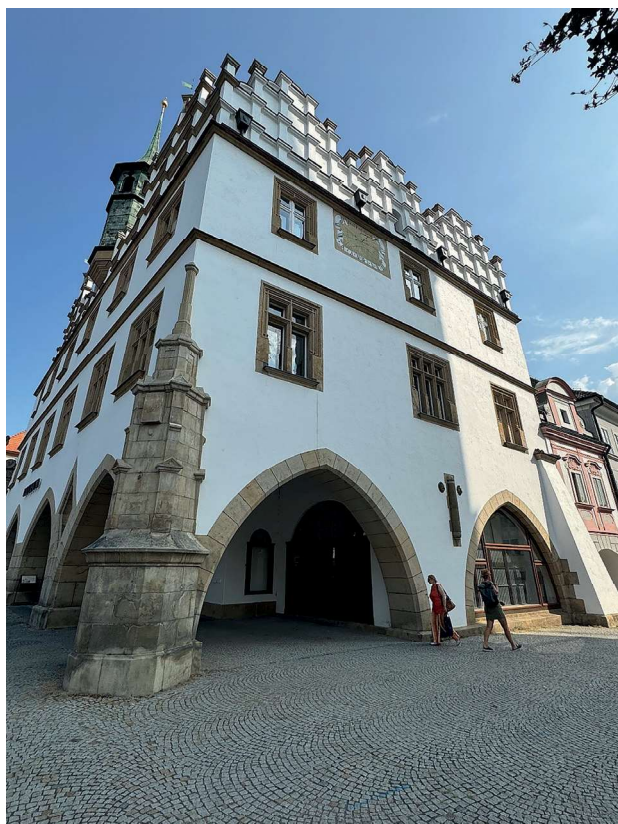
Obr 1. Pohled na jižní průčelí se slunečními hodinami. Foto: autorka, 2024
