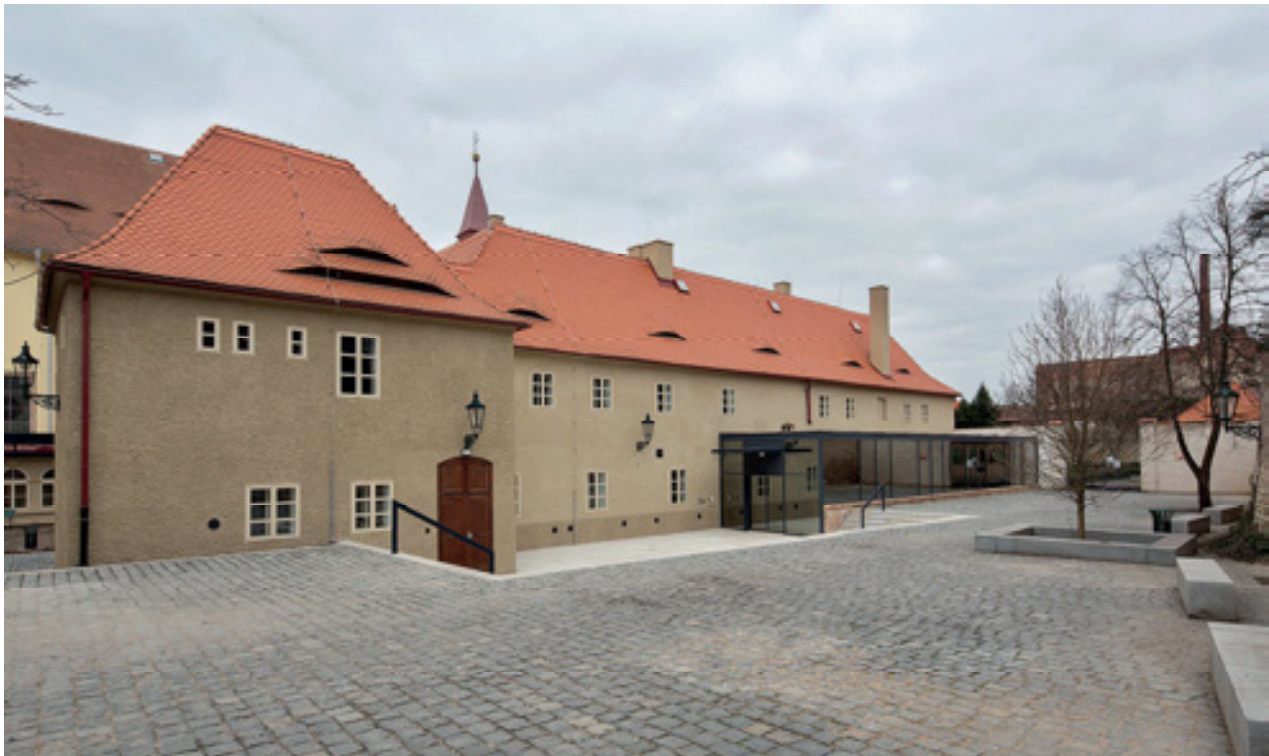
Obr 1. Záchodový rizalit a jižní křídlo v pohledu od jihozápadu po dokončené opravě. Foto: Kateřina Neumannová, 2024
