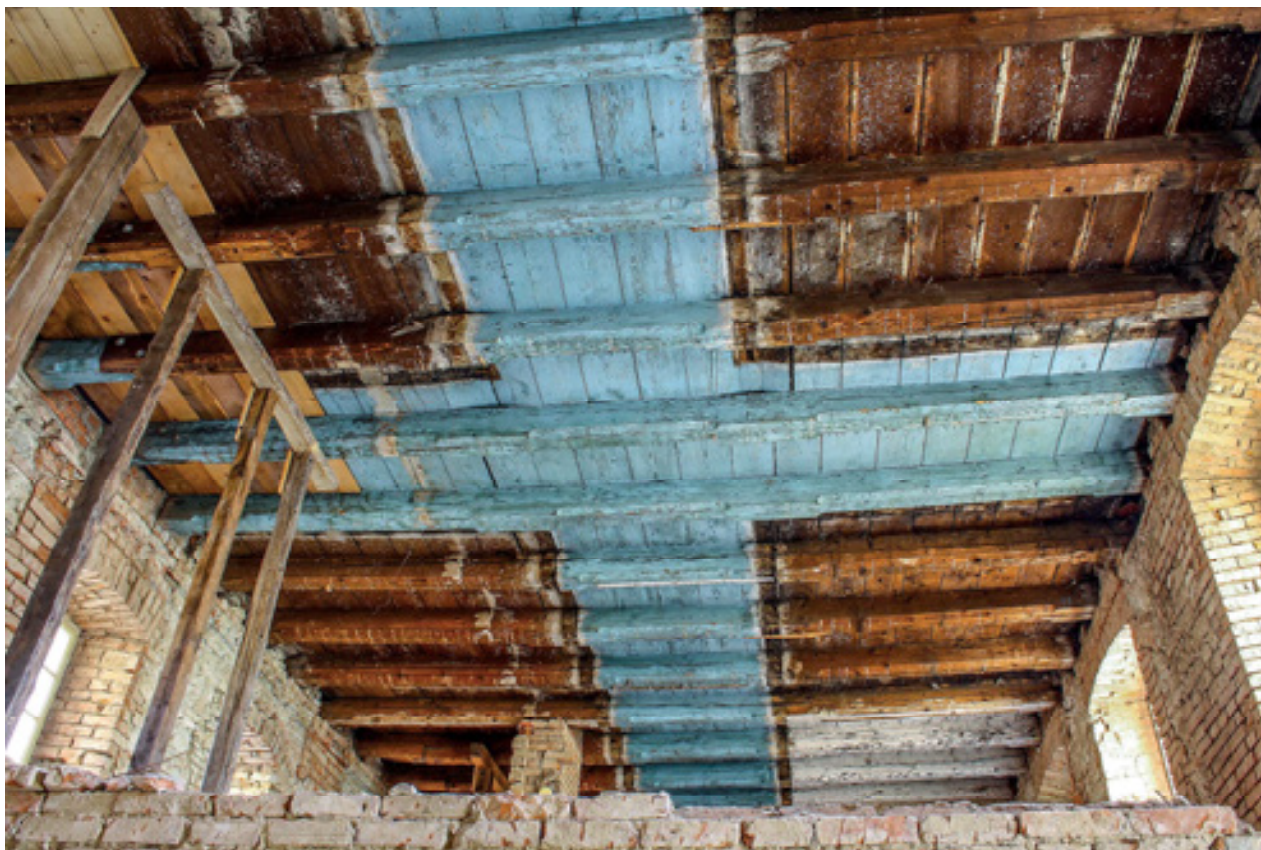
Obr 10. Strop prvního patra západního křídla v pohledu od severu. Šedomodře je malovaná plocha náležející chodbám, která je rámována otisky po příčkách barokních cel. Foto: Jaroslav Skopec, 2017
