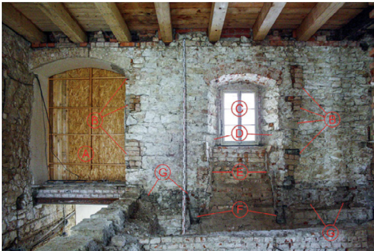
Obr 6. Severní konec východní strany prvního patra západního křídla v pohledu od západu. A – Vstup do severního křídla; B – Zazděné kapsy po zavázání zaniklé příčky mnišské cely; C – Okenní otvor mnišské cely; D – Odlišný sklon špalet okenní niky nejasného účelu; E – paty ostře ven stoupajícího záklenku arkádového otvoru; F – kapsy pro zavázání odstraněného trámového překladu arkádového otvoru; G – kapsy pro zavázání odstraněných stropních trámů. Foto: Jaroslav Skopec, 2017
