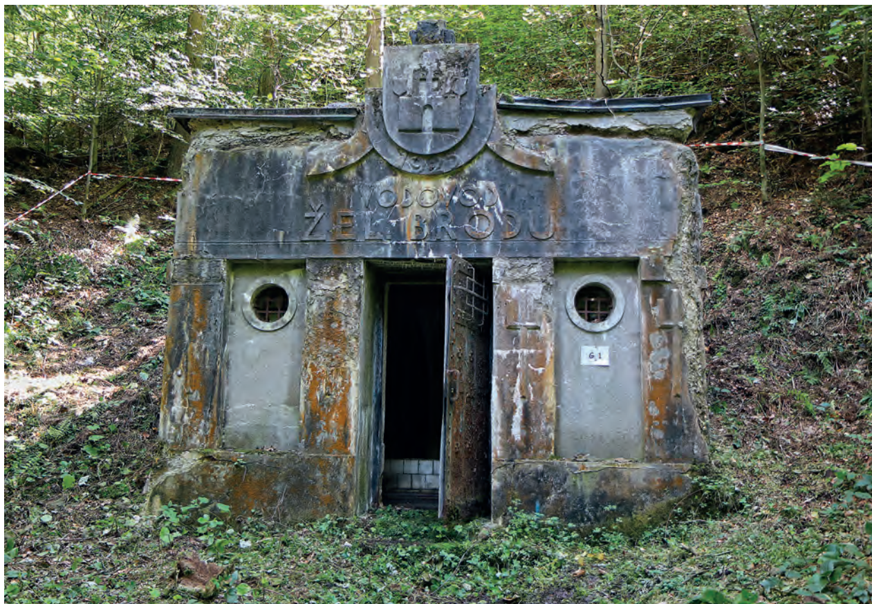
Obr 8. Smrčí, jímací objekt. David Šťastný, 2025
