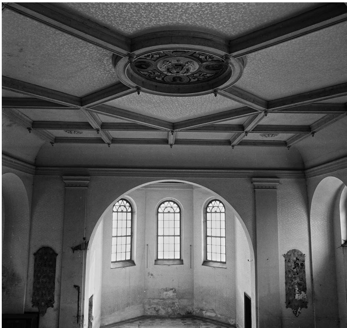
Obr 15. Kostel sv. Michaela, interiér, pohled na strop lodi od jihovýchodu, foto Ludmila Skokanová 1992, NPÚ ÚOP v Ústí nad Labem
