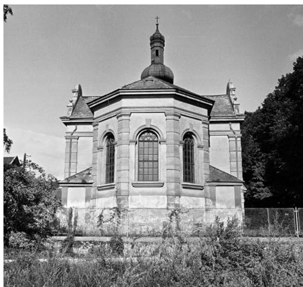
Obr 10. Kostel sv. Michaela, jihovýchodní průčelí presbytáře, pohled od jihovýchodu, foto Ludmila Skokanová 1992, NPÚ ÚOP v Ústí nad Labem
